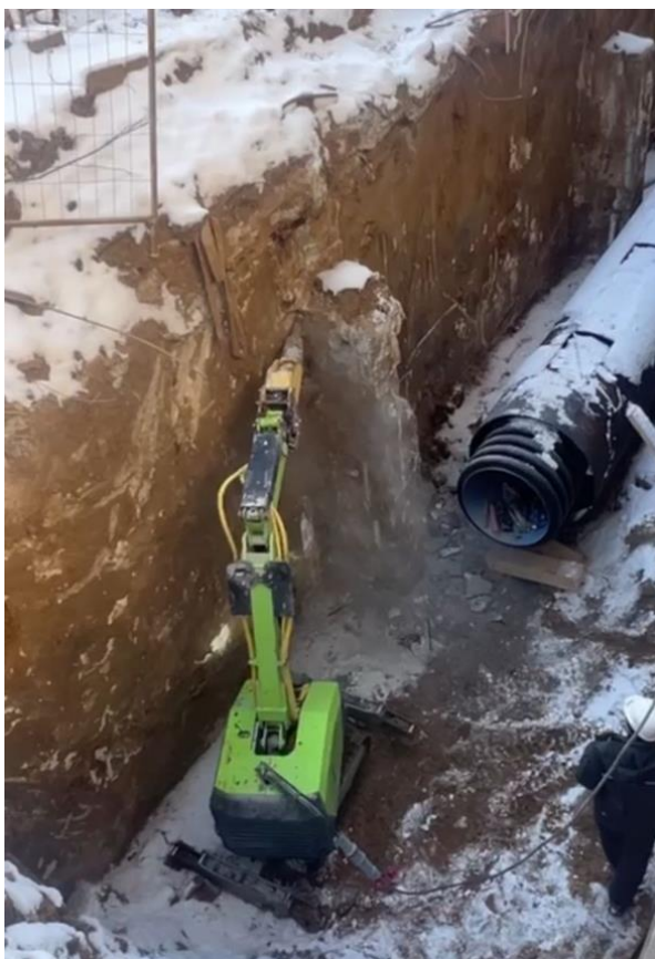
Рис. 4. Демонтаж роботизированным экскаватором обнаруженных бетонных частей зданий и сооружений не отмеченных на чертежах
