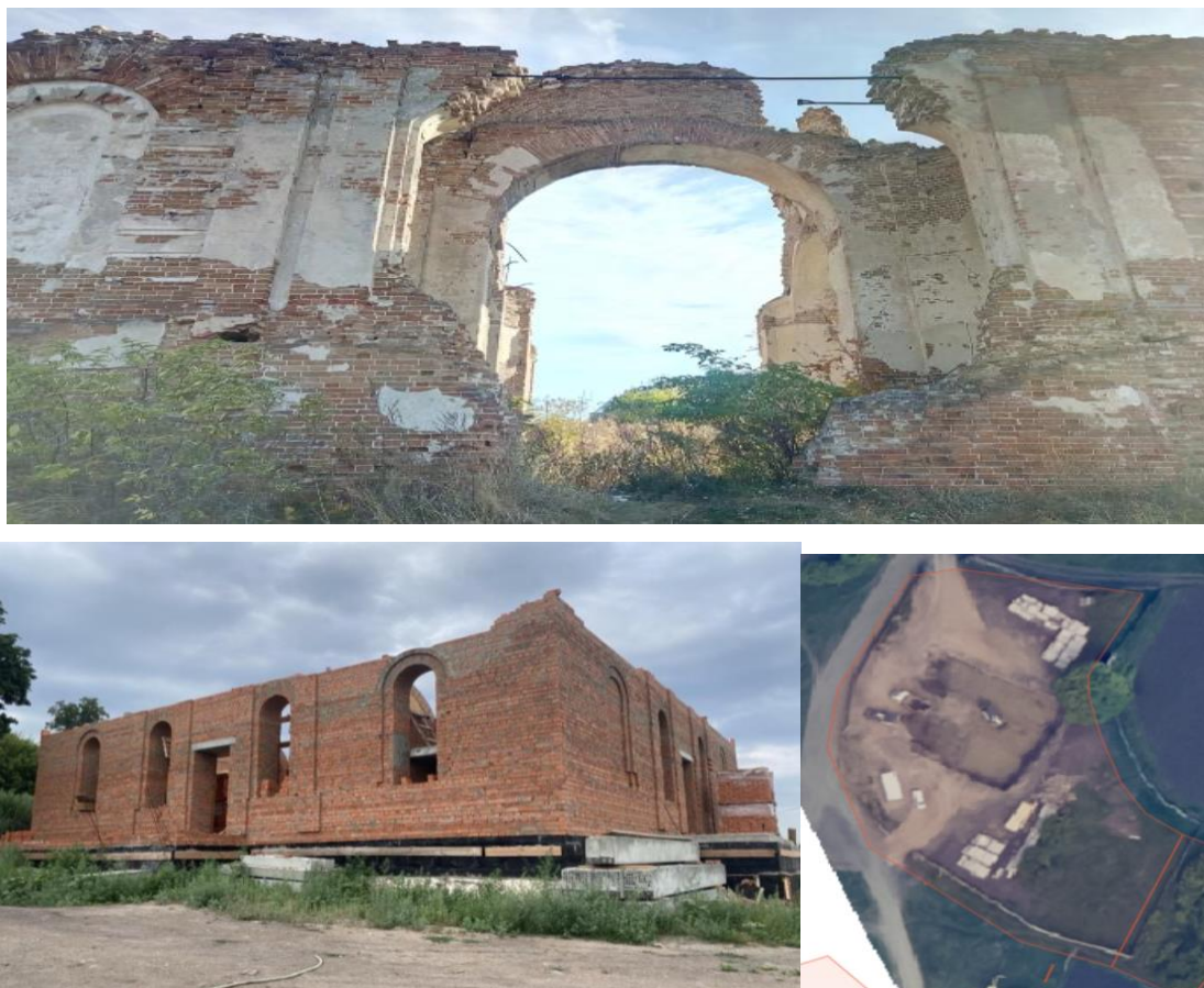
Рис. 4. Восстановительные работы в с. Воскресеновка
