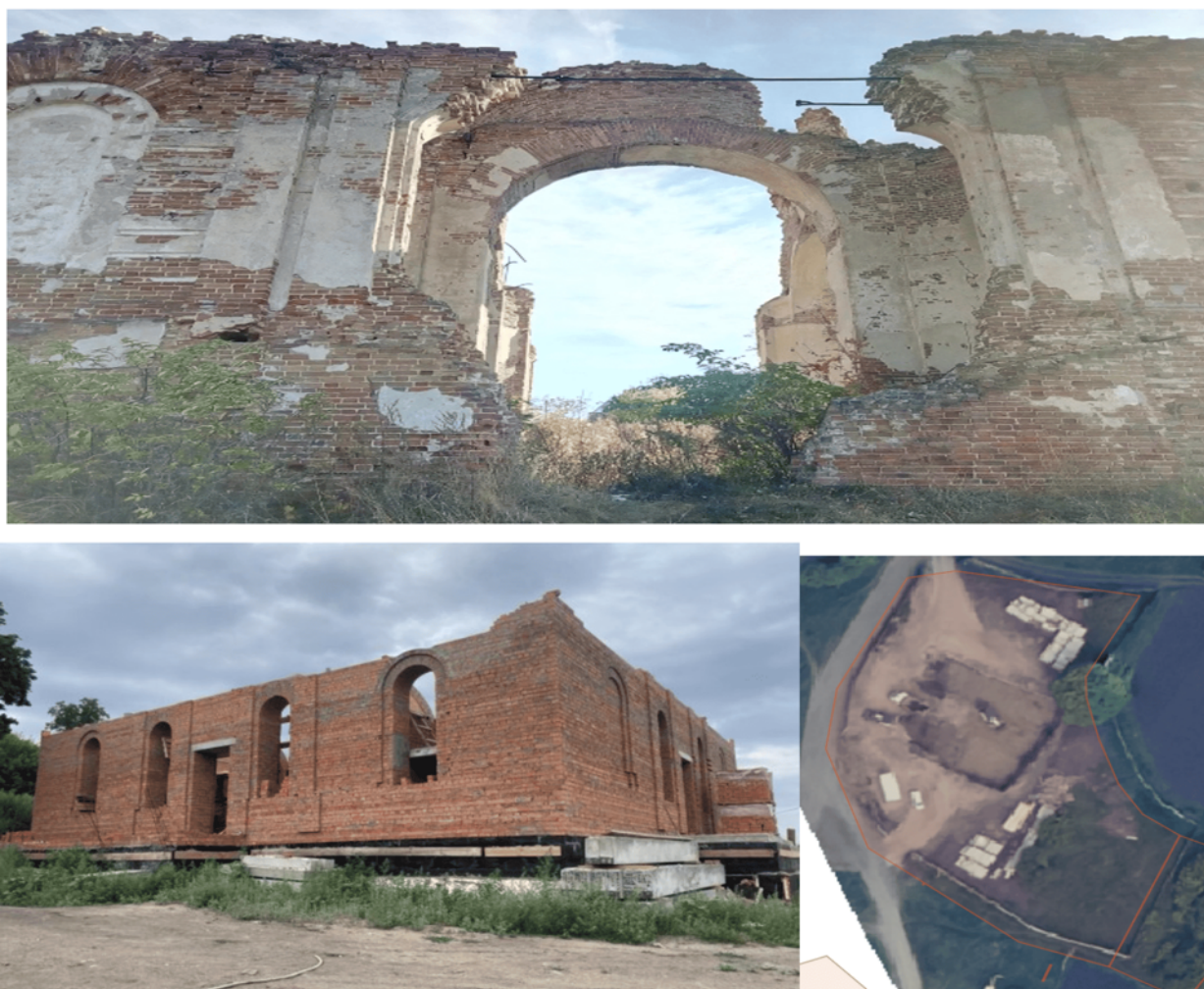
Рис. 4. Восстановительные работы в с. Воскресеновка
